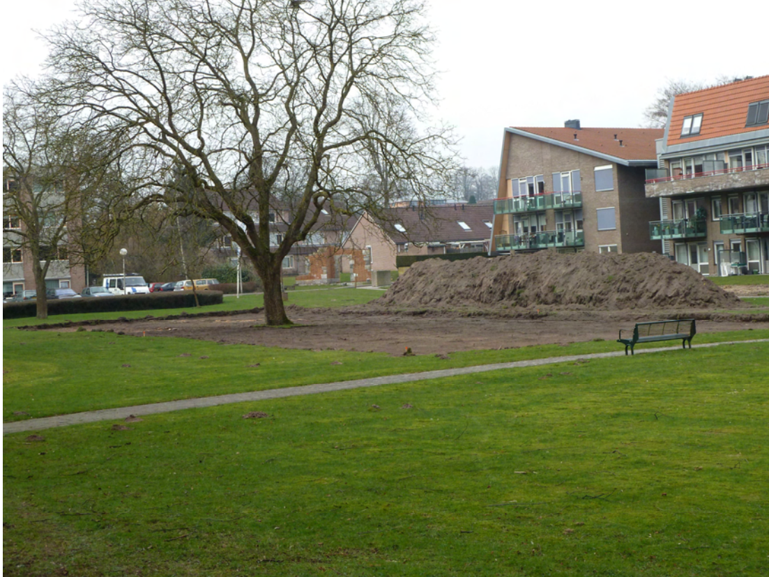
Foto: grondwerk op de locatie 'Mariendaal C' (genomen op 23 februari 2011)
